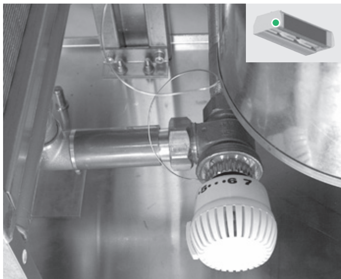
OBRÁZEK 14 – TERMOSTATICKÝ VENTIL TVW-R, CLONA D2
